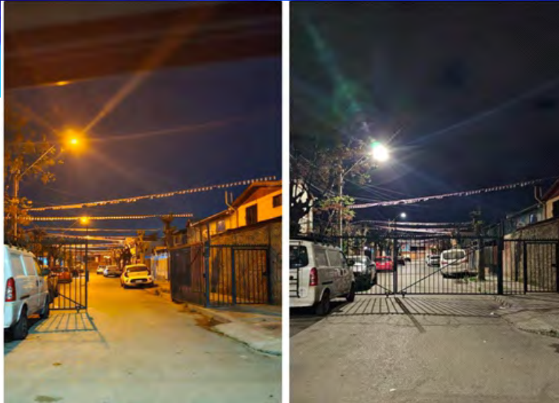
Foto 8. Recambio de luminaria de sodio (amarilla) a Led (blanca) año 2023 en pasaje Río Alvarado, Puente Alto.
